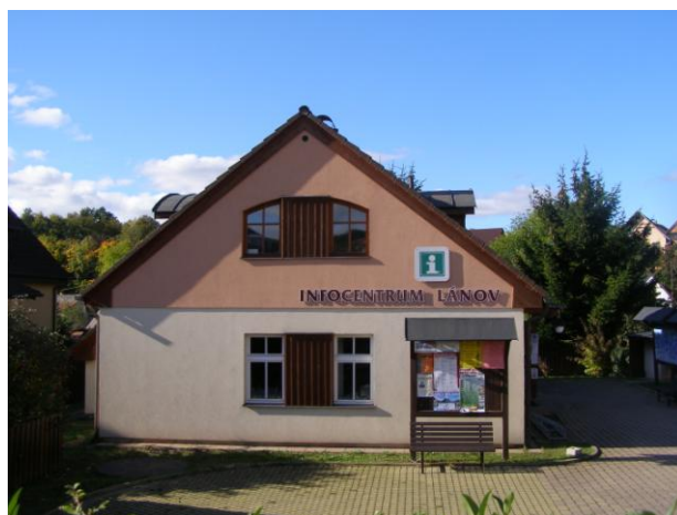
Knihovna v Lánově, která je umístěna v budově Infocentra
